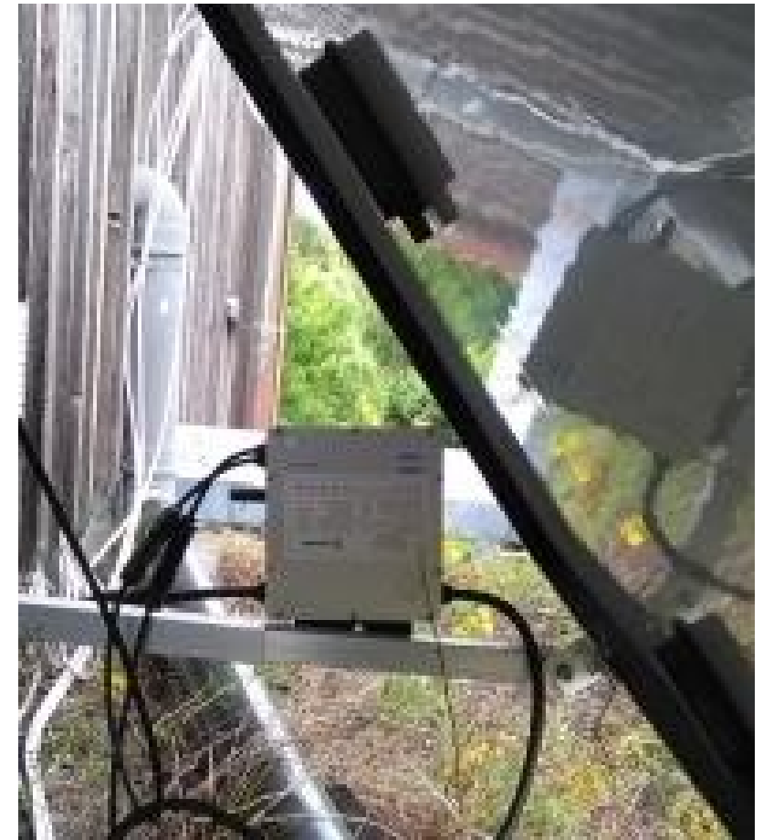
Modulrückseite mit Wechselrichter
