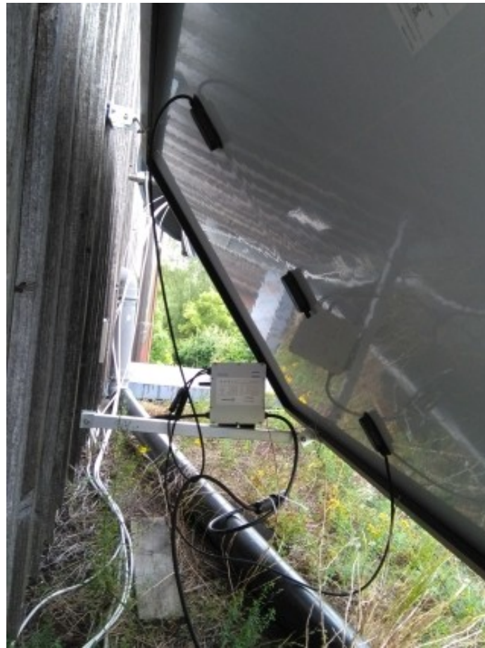
Modulrückseite mit Wechselrichter
