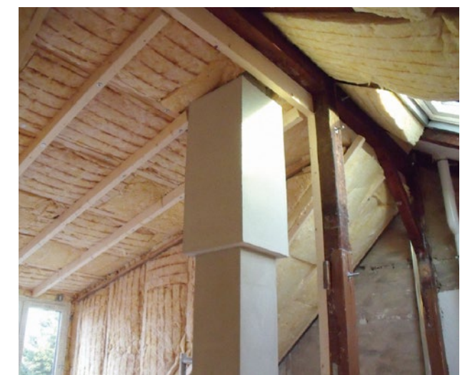
Abbildung 30 Begleitdämmung eines massiven Schornsteinkopfes
