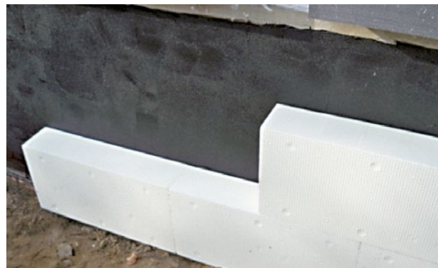
Abbildung 68 Angebrachte Perimeterdämmung im Sockelbereich
