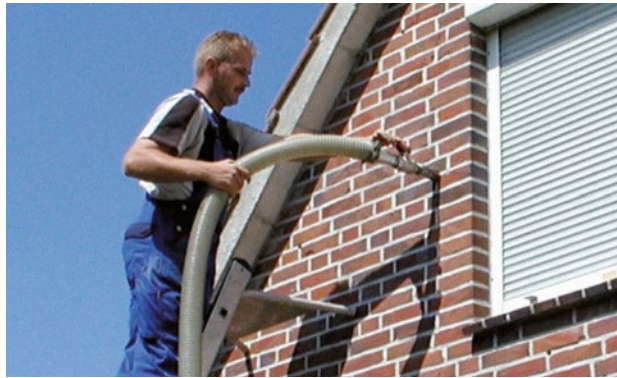
Abbildung 75 Einbringen einer Einblasdämmung (Bestand)
