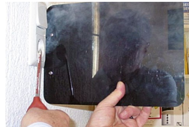
Abbildung 16 Verwendung von Rauchröhrchen
