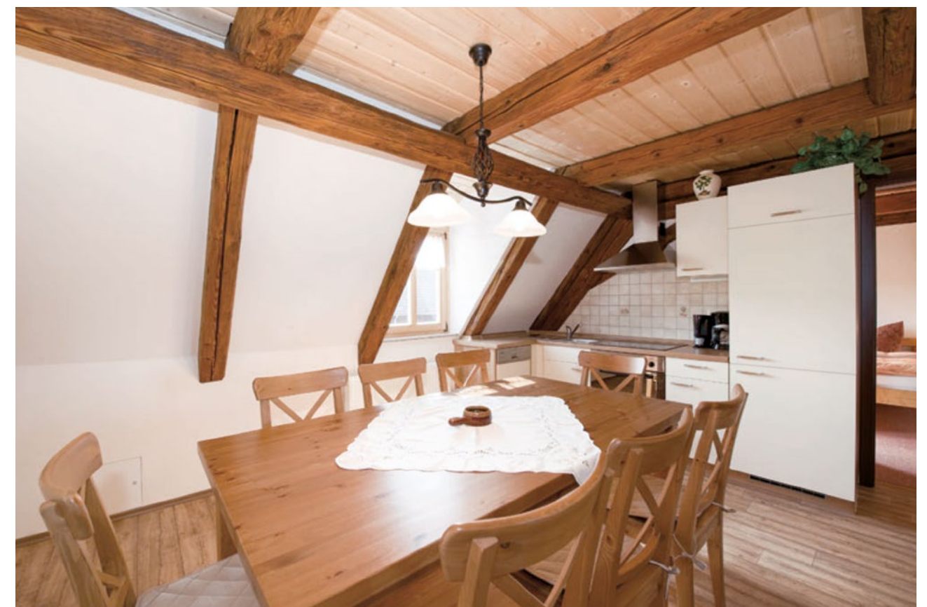
Abbildung 27 Ausgebautes Dachgeschoss unter Verwendung einer Aufsparrendämmung
