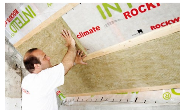
Abbildung 38 Einbau einer Untersparrendämmung zwischen die Konterlattung
