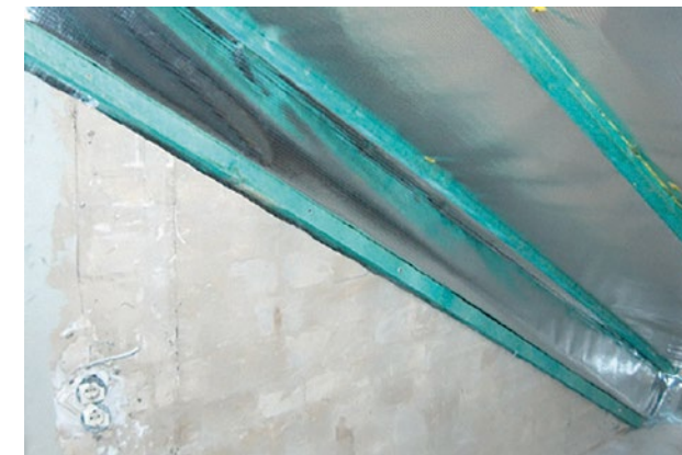
Abbildung 28/29 Möglichkeit einer Flankendämmung mit Mineraldämmplatten
