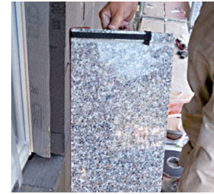
Abbildung 90/91 Fensterbank mit aufgeklebtem Quellband
