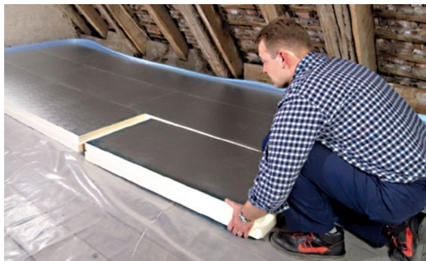
Abbildung 52 Einbau von druckfesten Hartschaumplatten
