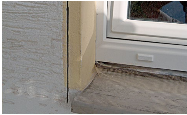
Abbildung 87 Massiver Mauerwerksanschlag wird eingeschnitten und abgebrochen
