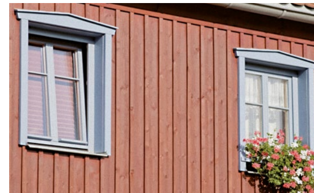
Abbildung 74 Rekonstruktion einer landestypischen Holzverschalung
