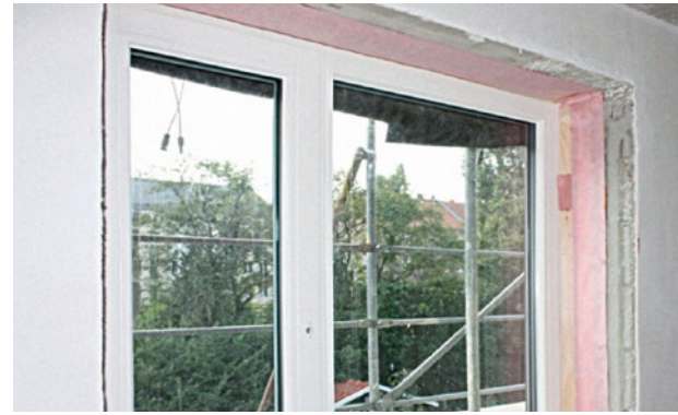
Abbildung 88 Einbau eines neuen Fensters mit Dichtklebeband
