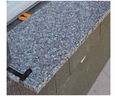
Abbildung 90/91 Fensterbank mit aufgeklebtem Quellband
