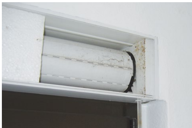
Abbildung 8 Rolladen ungedämmt
