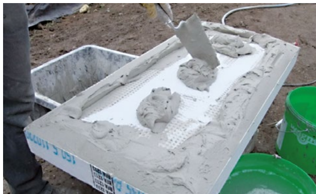
Abbildung 67 Verklebung einer Sockeldämmplatte im Wulst-Punkt-Verfahren
