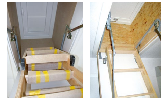
Abbildung 57/58 Neueingebaute Bodentreppen mit zusätzlich gedämmter Bodenklappe
