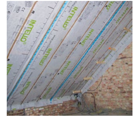
Abbildung 35 – 37 Vergrößerung des Sparrenzwischenraums durch seitlich angebrachte Sparrenexpander aus Holz
