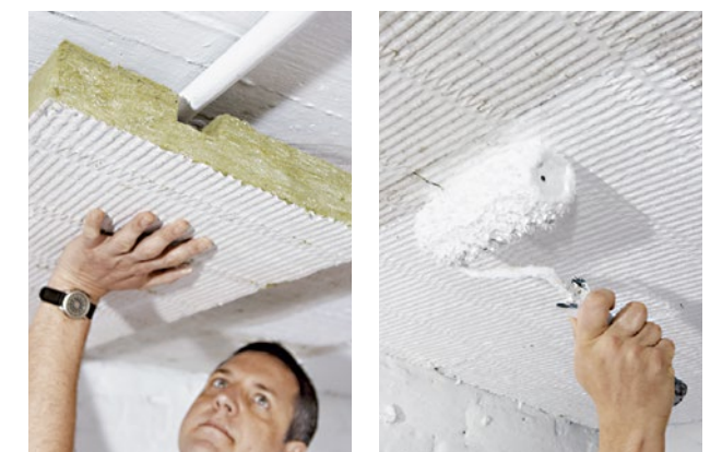
Abbildung 92/93 Anbringen einer mineralischen Unterdeckendämmung
