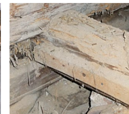
Abbildung 5 Problemstelle Auflagerbereich für Fußschwelle und Balkenköpfe
