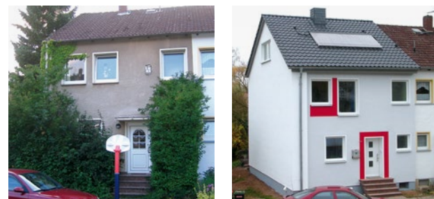
Abbildung 1/2 Erfolgreiche energetische Sanierung
