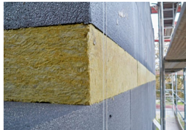
Abbildung 22 Brandriegel aus Mineralwolle
