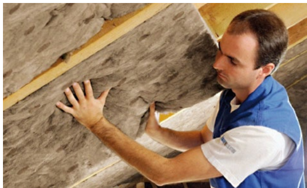
Abbildung 33 Einbau einer Mineralwolldämmung zwischen den Sparren
