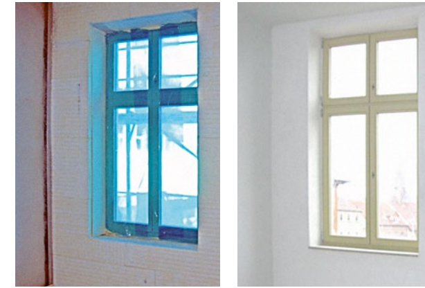
Abbildung 81/82 Einsatz eines Innenwand-Dämmsystems unter Einbeziehung der Fensterlaibungen
