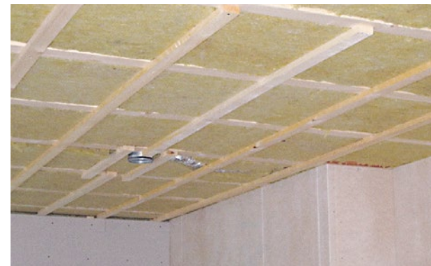
Abbildung 56 Einbau einer Unterdeckendämmung aus Mineralwolle
