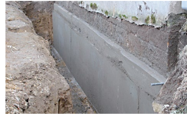
Abbildung 97 Betonierte Vorsatzschale einer Kelleraußenwand
