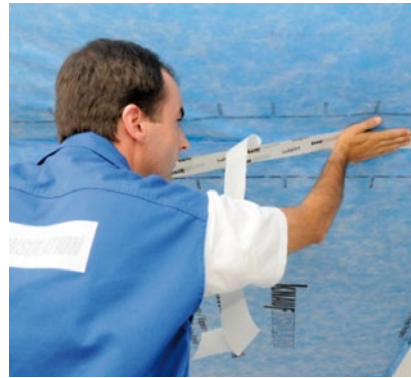
Abbildung 47 Verkleben der Folienstöße mit speziellem Klebeband
