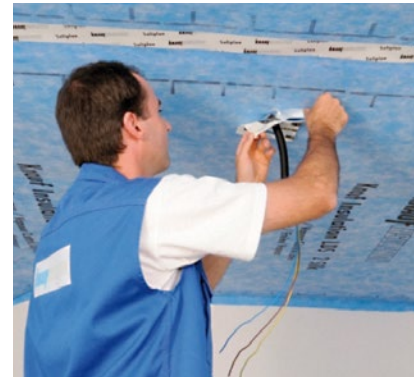
Abbildung 48 Verkleben einer Kabeldurchführung mit Kabel-Manschette
