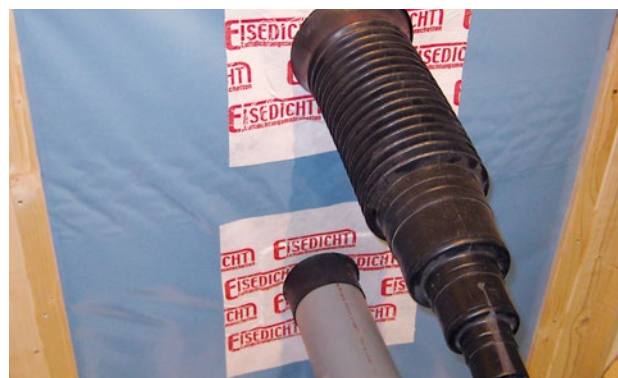
Abbildung 50 Verwendung von Luftdichtungsmanschetten für verschiedene Rohrdurchführungen
