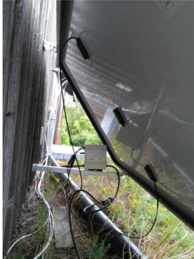
Modulrückseite mit Wechselrichter
